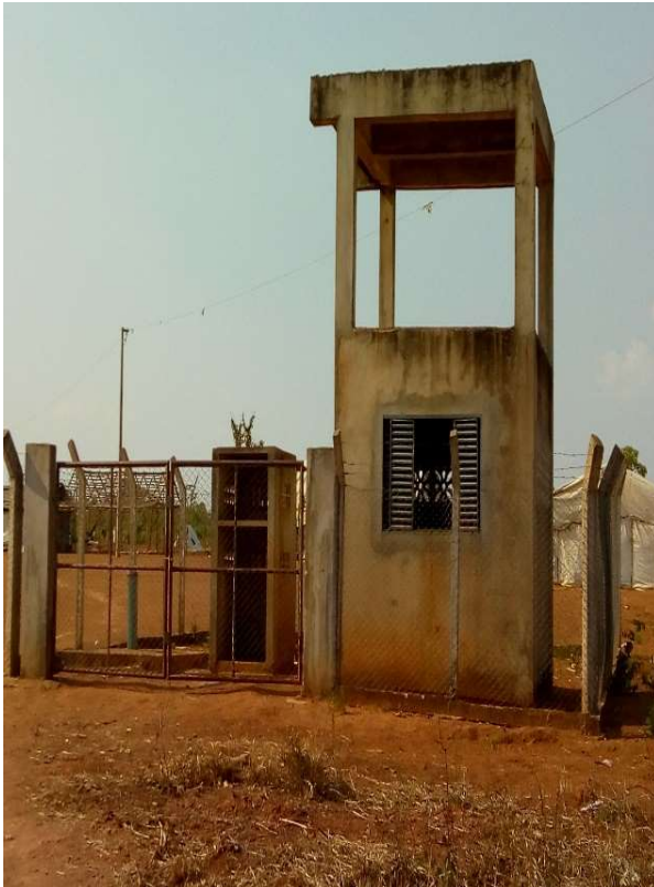
Figura 11: estrutura da estação de água que foi iniciada na aldeia.
